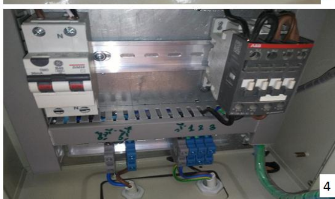
شكل (٢-٥): صور لمنظومة التشغيل والمسيطر الحراري للمفاعل
